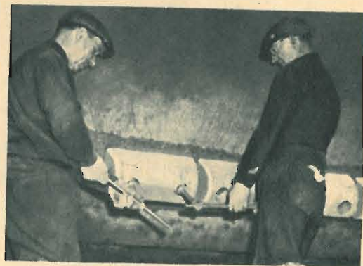
Nel bacino di carenaggio di Brooklyn due operai, dopo la saldatura dei bulloni allo scafo, provvedono al fissaggio della rotaia di magnesio.
