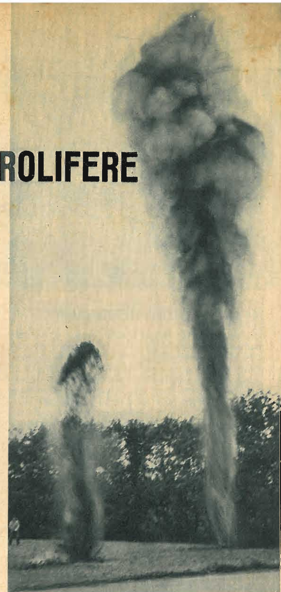
● Le onde sismiche prodotte dallo scoppio si tramettono attraverso il terreno e vengono ricevute da vari sismografi posti nella zona circostante.
